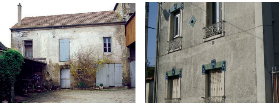
Bâti de ferme avec une façade en enduit lissé, maison de village avec un enduit projeté
