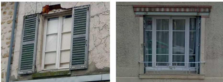
Menuiseries, contrevents et persiennes en lien avec l'architecture de la façade
