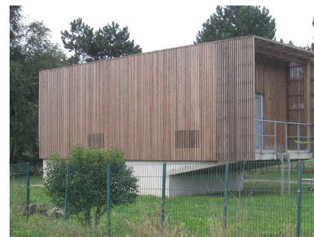
Construction de la plaine maraîchère réalisée avec un bardage bois
