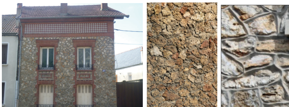
Façade en meulière et brique et détail de rocaillage et de joint au ruban
