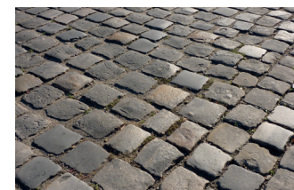
PAVÉ + JOINTS DE TERRE ET CHAUX
