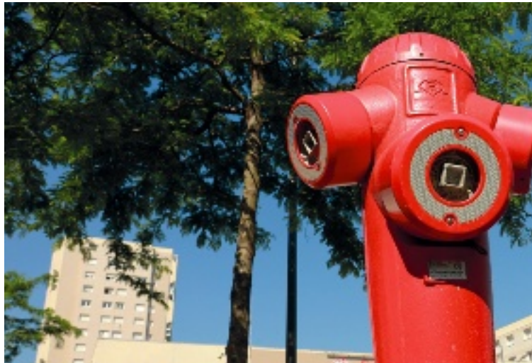
En plus de gaspiller de l'eau, ouvrir les bouches d'incendie est une pratique interdite et dangereuse.
